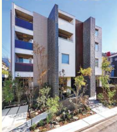
■4階建重量鉄骨造マンション「ベレオ」 ※写真は2021年11月撮影
